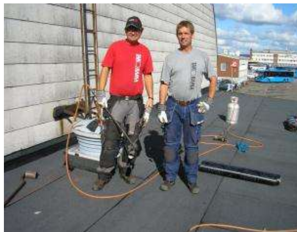
Nöjda takläggare efter färdigt arbete, Rolf Arvidsson och Martin Nilsson
