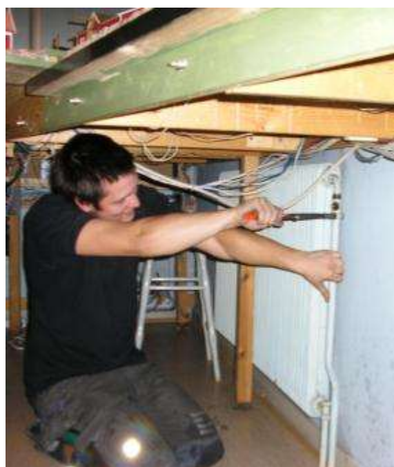
Rörläggare Alexander Milkovic byter ventil under anläggningen
